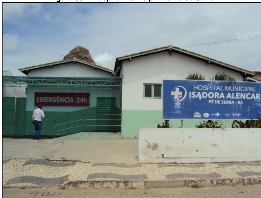
Figura 59 – Hospital Municipal de Pé de Serra.
