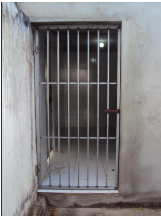
Figura 197 – Baia com fechadura para o armazenamento das bombonas com RSS do Hospital Municipal de Várzea da Roça.
