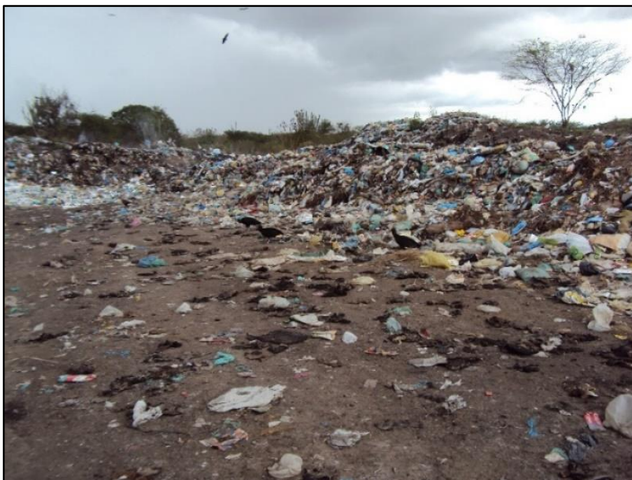
Figura 85 – Vazadouro a céu aberto de Nova Fátima.
