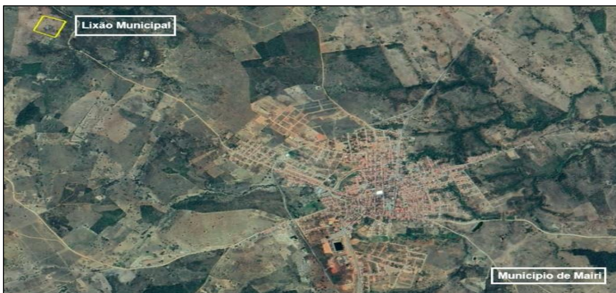
Figura 293 – Localização do vazadouro a céu aberto.
