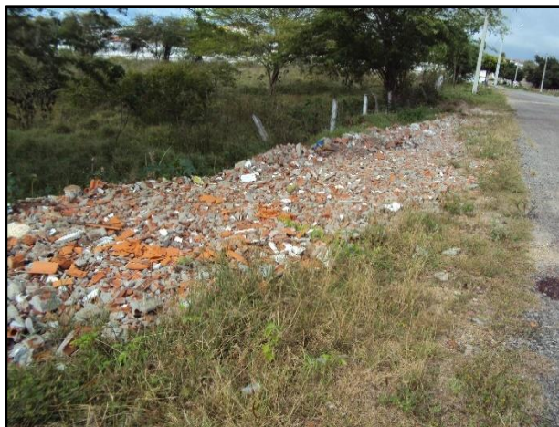
Figura 77 – Ponto de disposição irregular de RCC.
