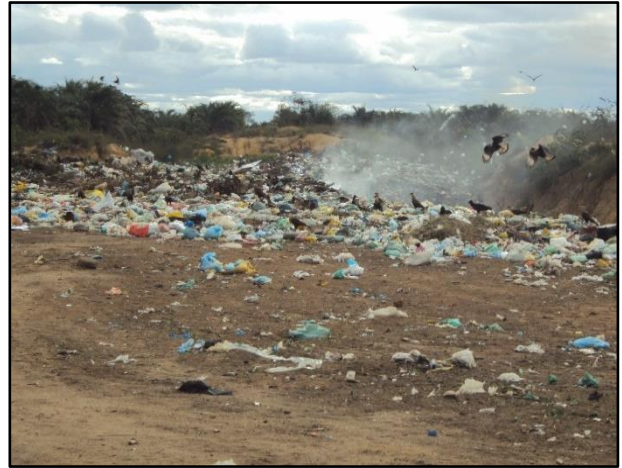
Figura 213 – Foco de incêndio.
