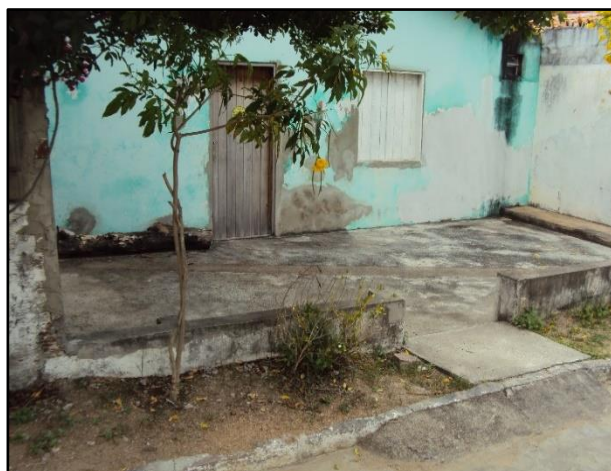
Figura 39 – Sede da COOBAPS, PEV de resíduos recicláveis.
