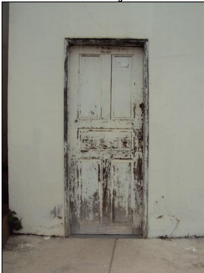
Figura 230 – Baia com fechadura para o acondicionamento dos RSS do Hospital Municipal de Capela do Alto Alegre.
