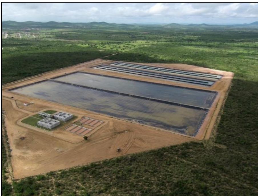
Figura 307 – Imagem aérea da Estação de Tratamento de Esgoto de Ipirá.
