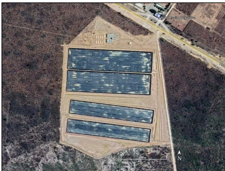
Figura 308 – Imagem de satélite da Estação de Tratamento de Esgotos de Ipirá.
