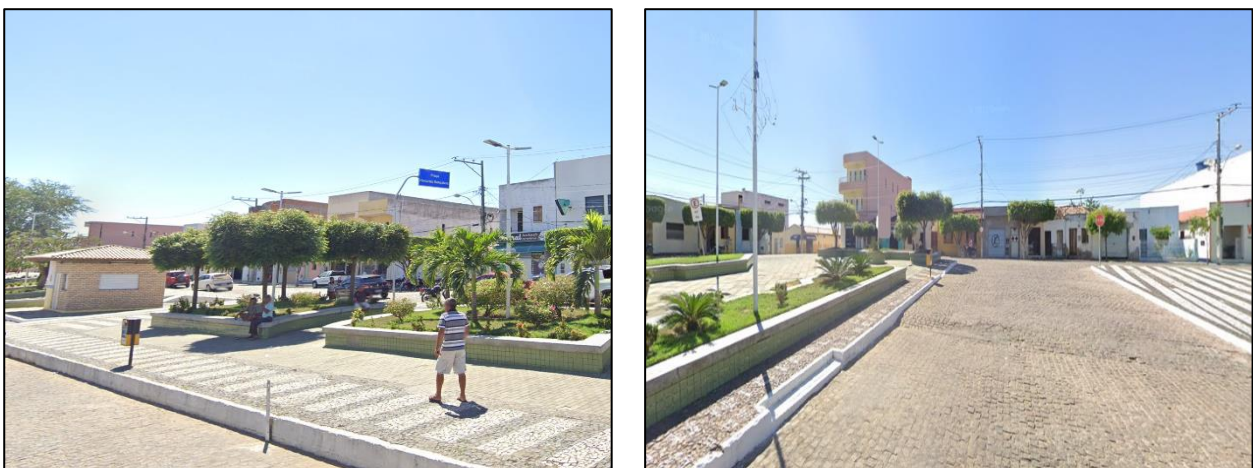
Figura 332 – Locais com boa execução do serviço de limpeza pública.
