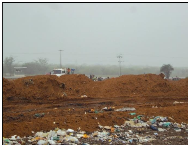
Figura 122 – Vazadouro a céu aberto de Capim Grosso.
