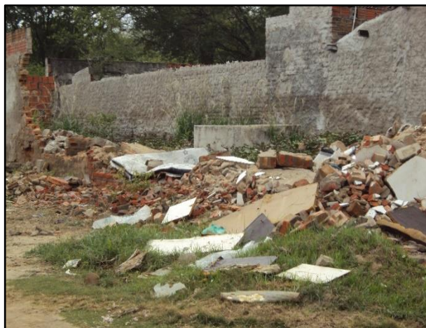
Figura 156 – Detalhe do RCC disposto inadequadamente.
