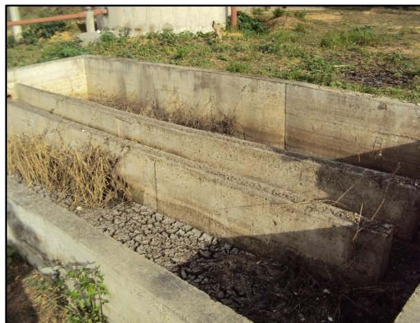
Figura 200 – Leito de secagem 2.
